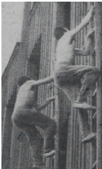
V roce 1945 byla vypracována pravidla soutěží v požárním sportu. Jednou z disciplín byl i výstup do 4. podlaží cvičné věže po hákové žebříku
