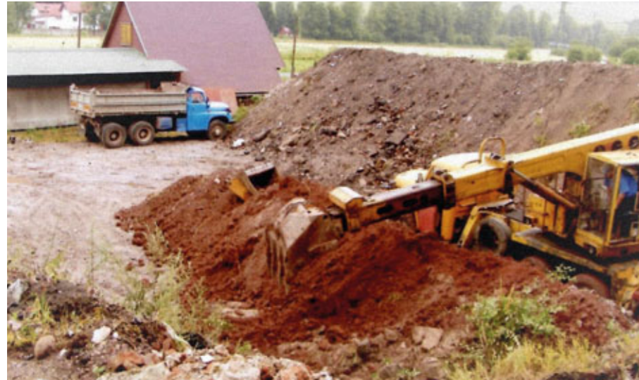
Výstavba střelnice v Hostinném
